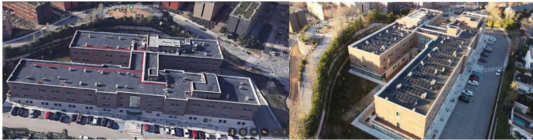
INSTALACIÓN INDUSTRIAL. Madrid (AMAVIR Pozuelo). 120Kw
