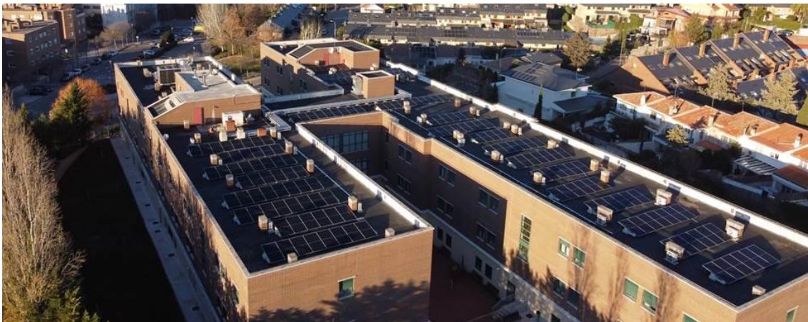
INSTALACIÓN INDUSTRIAL. Madrid (AMAVIR Arganzuela). 100Kw
